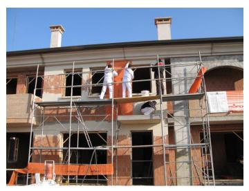
In langen Bahnen wird Erdbebenschutzgewebe auf Mauerwerk aufgebracht und dann verputzt. Im Ernstfall hält es Trümmer zusammen und Rettungswege frei. (Bild: M. Urban/KIT)
