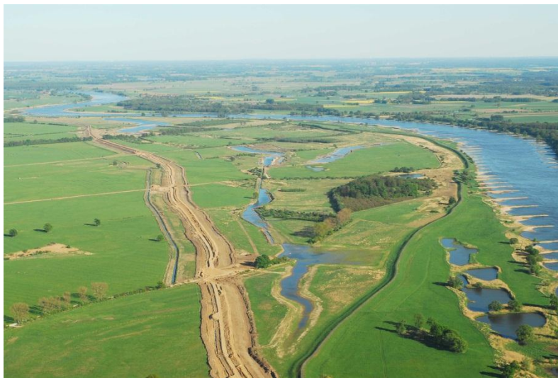
Deichrückverlegung: rechts die Elbe und der Altdeich, links die Neudeichbaustelle. (Luftbild: Jochen Purps)
