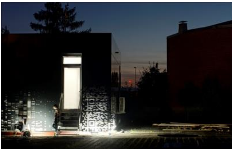
LOBSTER bei Nacht: Die Fassade besteht aus Aluminium-Verbundplatten, die computergestützt gefräst wurden. (Foto: Robin Nagel/Moritz Karl)
