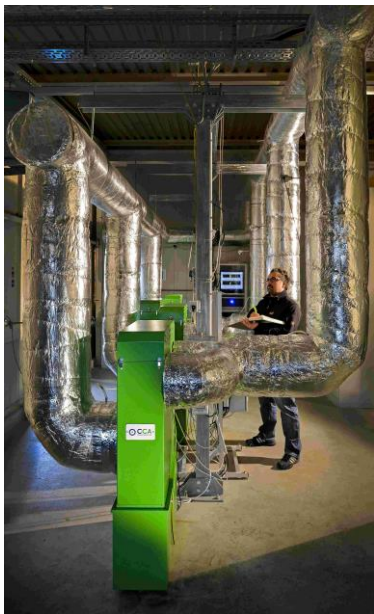
Der CCA-Abscheider (hellgrün) entfernt effektiv Feinstaub aus dem Rauchgas von holzbefeuerten Kesselanlagen. (Bild: KIT)
