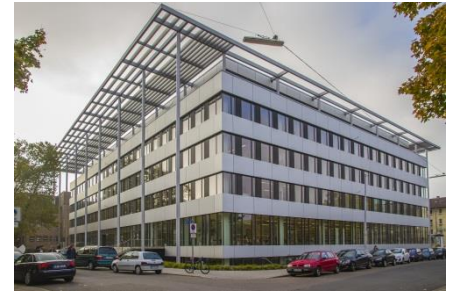
Doppelte Nutzfläche, halber Energieverbrauch: das sanierte Mathematik-Gebäude am KIT-Campus Süd (Foto: Manuel Balzer, KIT)
