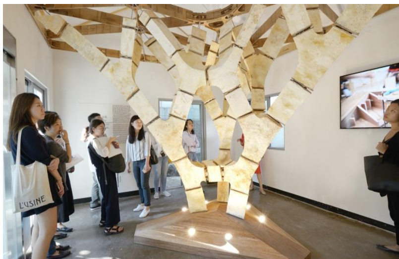
Der „Mycotree“, eine Struktur aus Pilzmyzelium und Bambus. Die Geometrie wurde mit Methoden grafischer Statik in 3D optimiert und tragfähig gemacht. (Foto: Carlina Teteris)
