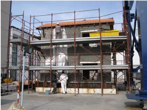
*Großversuch in Pavia: Ein stark beschädigtes Gebäude wird mit der seismischen Tapete verstärkt und anschließend auf einem Rütteltisch getestet. (Foto: Moritz Urban)*
