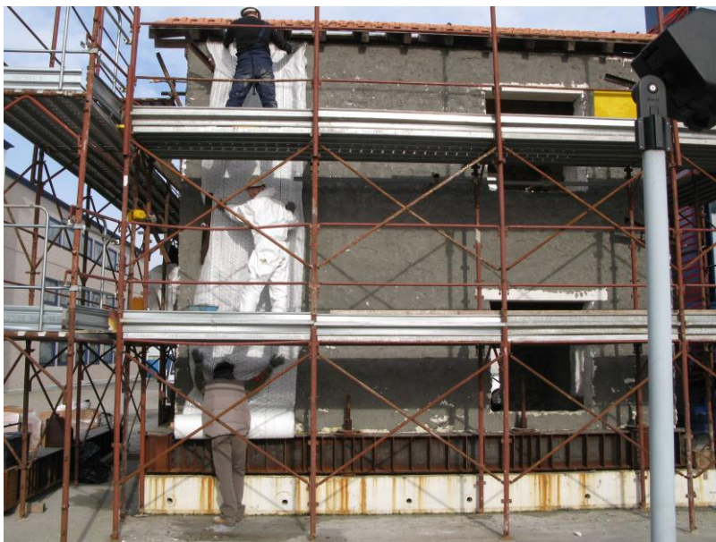
An einem zweistöckigen Gebäude in der italienischen Stadt Pavia testeten die KIT-Forscher die Schutzwirkung ihrer seismischen Tapete. (Foto: Moritz Urban)
