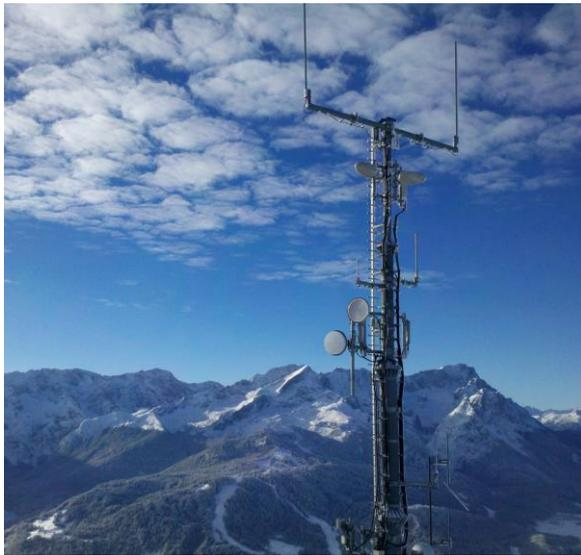
Aus den Strahlungsschwankungen zwischen Sendemasten von Mobilfunkbetreibern können Meteorologen Informationen über Regenfälle ableiten.
