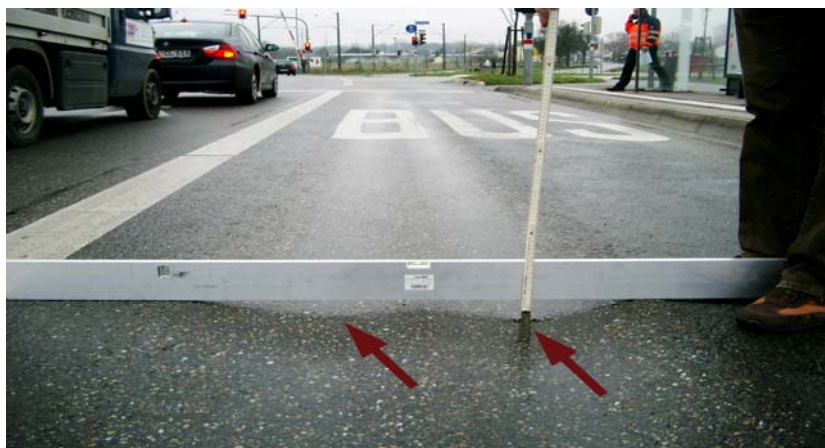
Klimaveränderungen wirken sich auch auf die Beschaffenheit der Straße aus: Spurrinnenbildung zählt zu den möglichen Folgen. (Foto: ISE).
