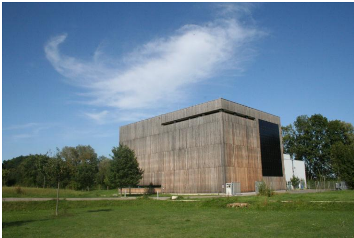
Ein Biomasse-Blockheizkraftwerk ist integraler Bestandteil des Projekts in Ostfildern. (Foto: Ursula Pietzsch, Hochschule für Technik, Stuttgart)
