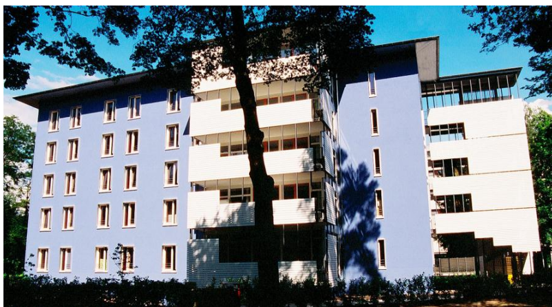
Setzt eins drauf: Drei Gebäude des Hadiko erhalten eine weitere Etage. (Foto: Markus Riecker, KIT)
