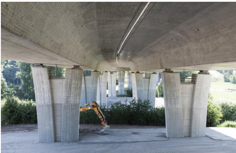
Forscherinnen und Forscher des KIT arbeiten an einem Verfahren, das es möglich machen soll, Schäden am Brückenbauwerk früher zu erkennen (Foto: Markus Breig, KIT)
