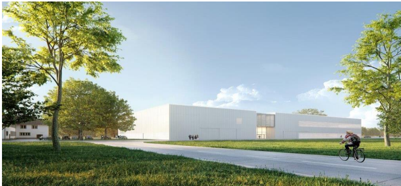
Unreife Produktionsprozesse in neuer Geschwindigkeit serienreif machen – das ist das Programm der im Bau befindlichen Karlsruher Forschungsfabrik. (Abb.: Heinle, Wischer und Partner, Freie Architekten)
