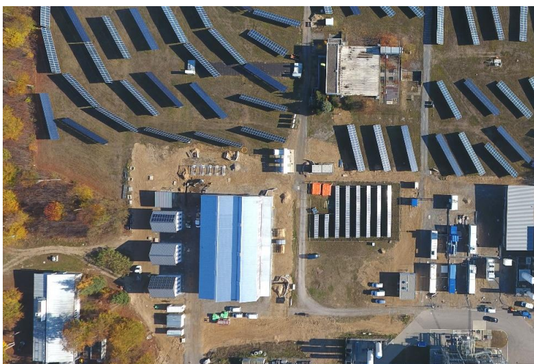
Luftaufnahme der unterschiedlichen Energiesystemkomponenten auf dem Campus Nord des KIT. (Foto: Sebastian Mang, KIT)
